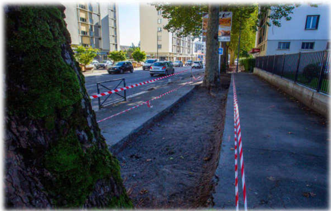
Figure 19 : Travaux de déminéralisation, ville de Nevers
